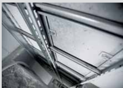
Fixing of cable conduits
